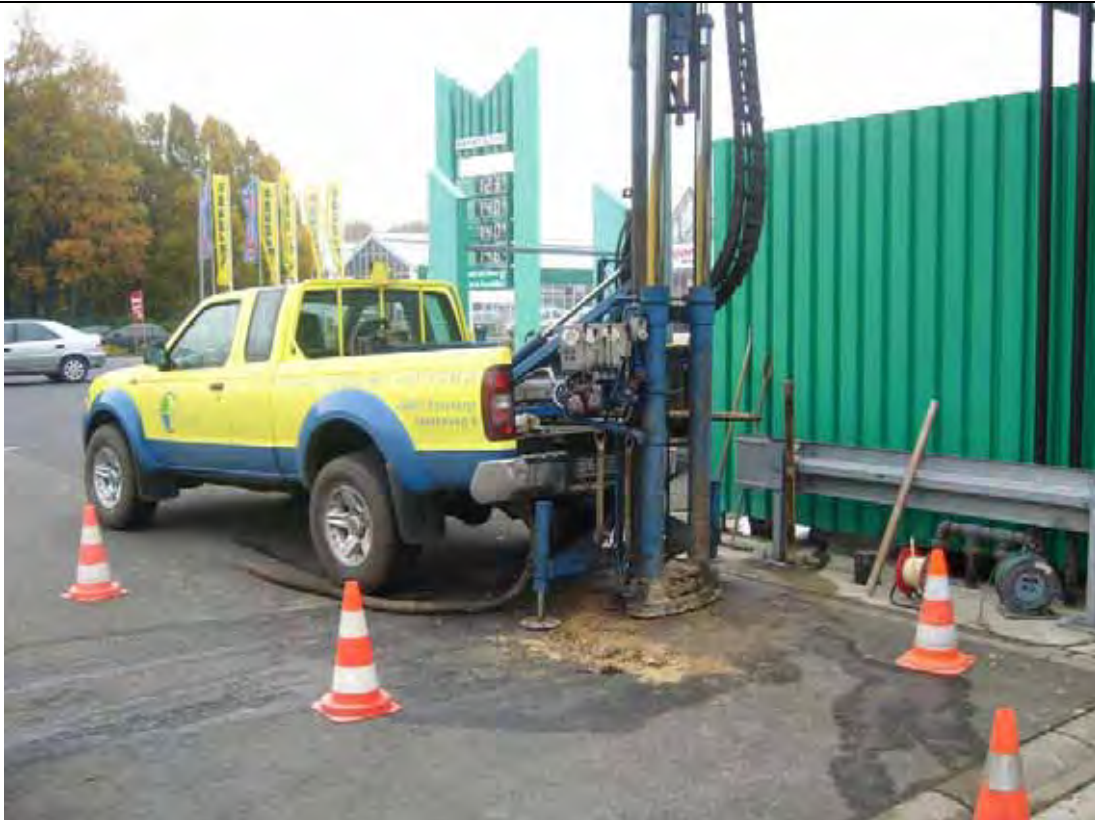
Foto 7: RKS 4 vor den Be- und Entlüftungsmasten, Blickrichtung nach Süden
