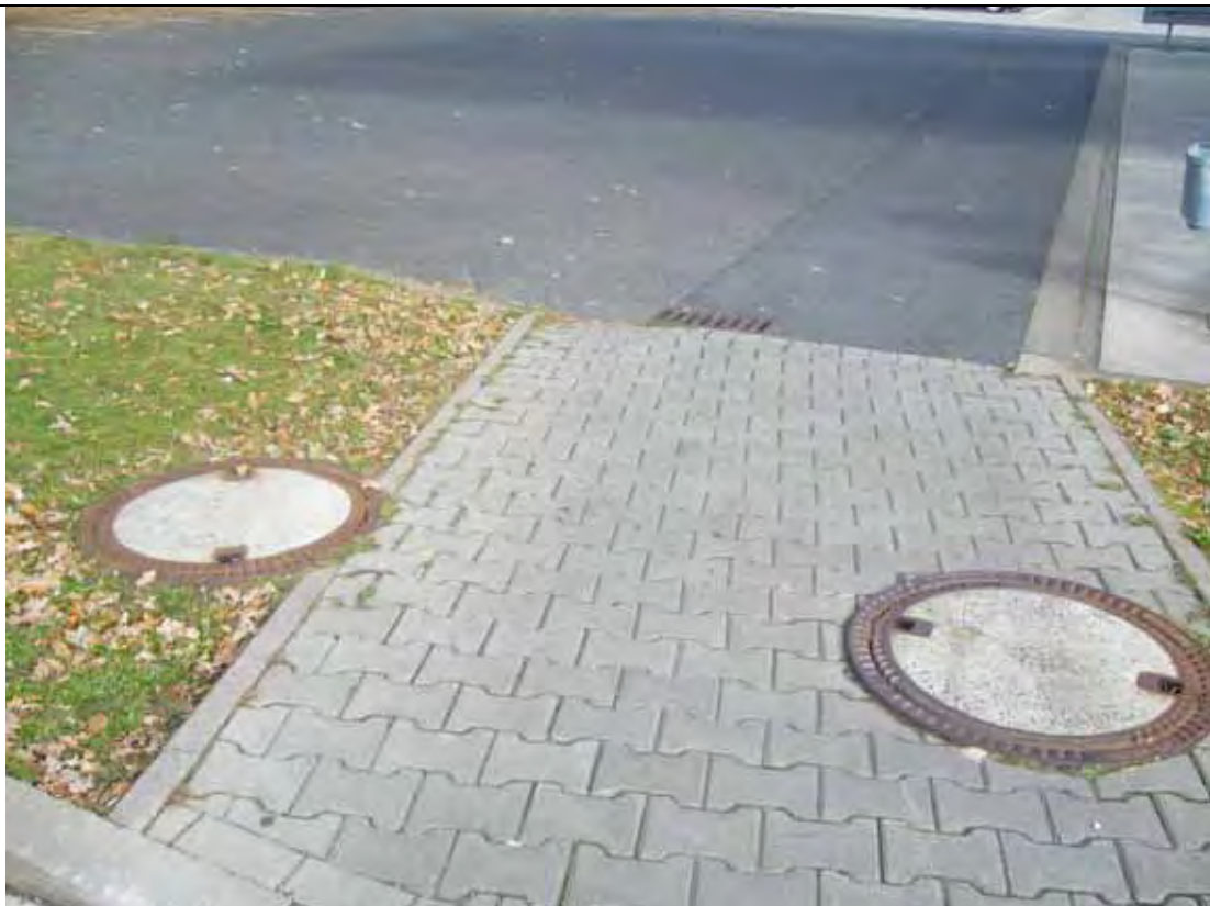
Foto 6: Abscheideranlage westlich der Betankung
