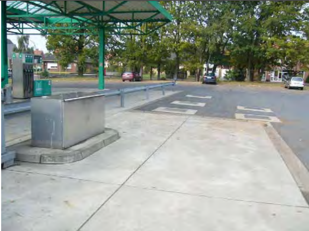
Foto 5: Oberirdischer Fernfüllschacht und Tanksfeld, Blickrichtung nach Nordwesten
