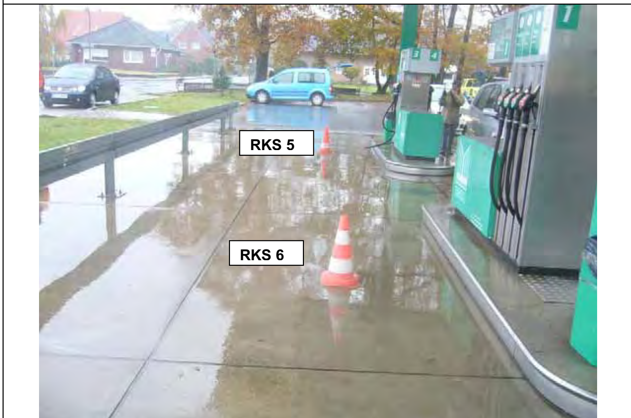
Foto 10: Bohransatzpunkte im Bereich der Betankung, Blickrichtung nach Nordwesten
