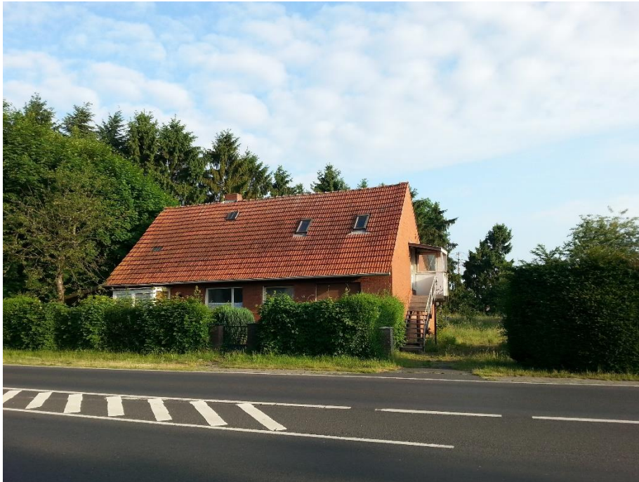
Abbildung 2: Lehrstehendes Gebäude, nördlich der Fullener Straße
